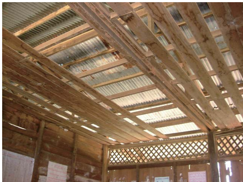
屋根はトタンで作られているが、今にもはがれ落ちてきそうな状態。下の写真は校舎の全景。
