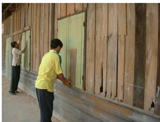
右は教室の様子。机や椅子もボロボロ。 屋根も壁も穴だらけ。
