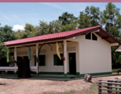
完成したタート・インハン小学校の 新校舎
