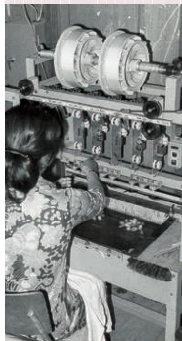
4条の小型製糸機を使っての製糸作業
