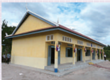
完成したベン・ロヴェア・レー小学校の新校舎
