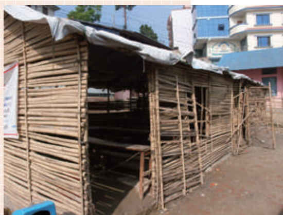
カトマンズ市内シタパイラ小・中学校の仮校舎
