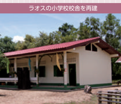
完成したタート・インハン小学校の新校舎
